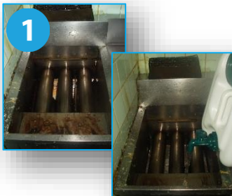
1 排油し、アルカリ性水を入れる。
